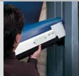
Languettes Break-Away réintroduites dans les colonnes latérales
